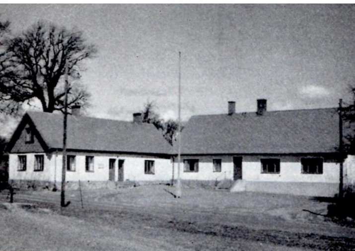
Skolhusen i Gärdslöv, uppförda 1847 och 1875. I den vänstra byggnaden fick Viktor sin första skolundervisning 1865-67.
